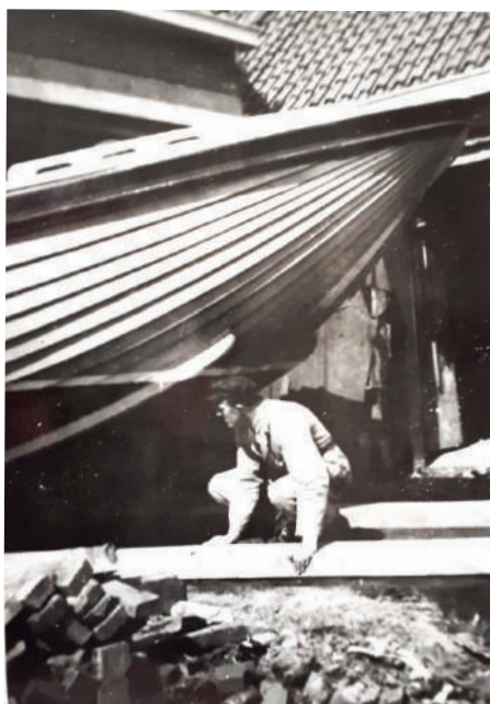
De vlet wordt uit de achterste werkplaats getrokken. Geert van Dijken legt nog even een balkje recht
