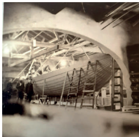
Als de spanten zijn ingebogen, komen de klinkers en tegenhouders in actie. Vooraan: Hendrik Ubels en Gerrit Schuil
