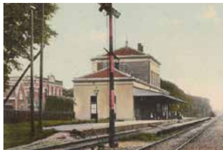
Station Hoogezand Sappemeer
