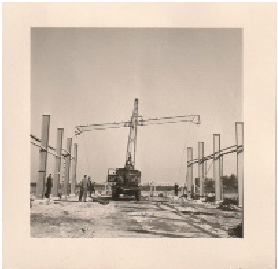
Opbouw zelfgemaakte spanten (1955)
