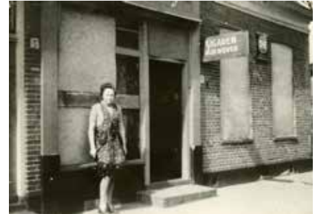
Mevrouw Wever-van Buizen staat hier in april 1945 voor het pand aan de Stationsstraat 6, terwijl de ramen zijn dichtgetimmerd om schade te voorkomen als de Bonthuiserbrug wordt opgeblazen door de terugtrekkende Duitse soldaten
